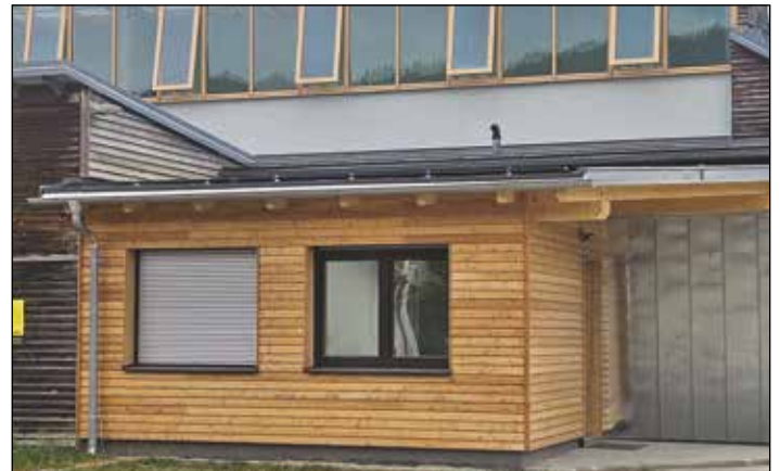
Der mittlerweile unansehnlich gewordene Container, der der Faschingsgilde Frauenstein als Aufenthaltsraum diente, wurde durch einen zur Volksschule passenden Zubau ersetzt.
