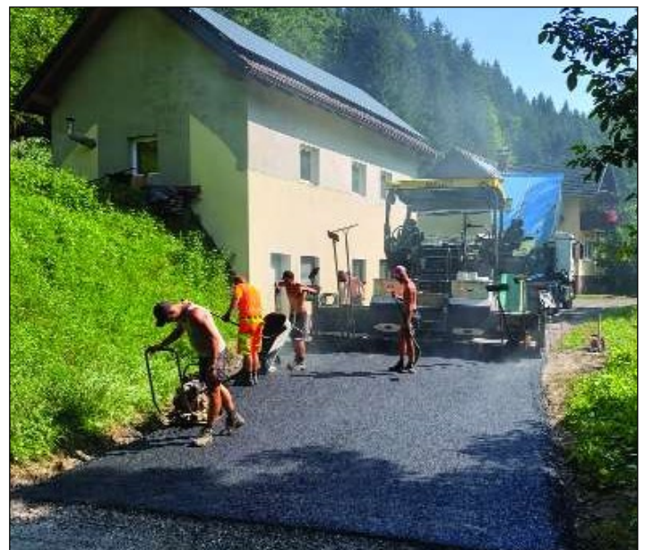
Eine "ewige" Baustelle ist leider die Straße in die innere Wimitz. Kleinere Abschnitte konnten aber heuer saniert werden.
