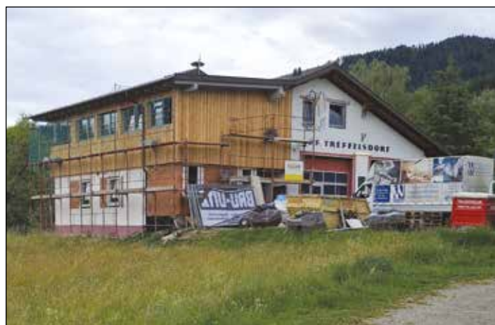
Die Zu- und Umbauarbeiten schreiten zügig voran.
